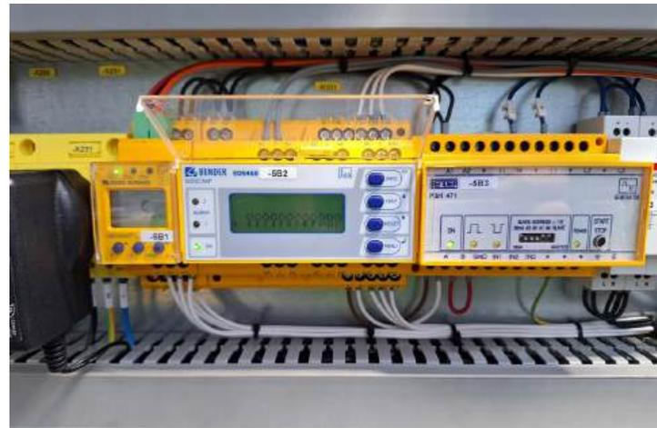
Schmales Gerät links: LPR-Messung (Low Parallel Resistance)
