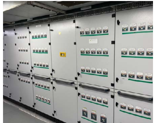
Die Notschaltanlage mit den überwachten Verbrauchergruppen vereinfacht die Fehlersuche.
