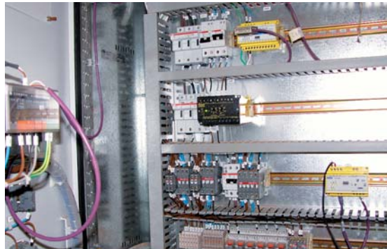
Bereich 350: Schaltschrank – Innenansicht
