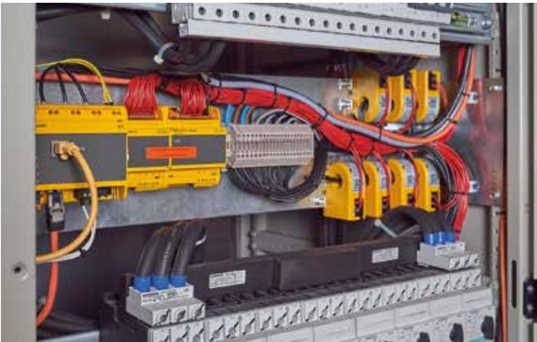
Messstromwandler sind wichtige Komponenten bei der Isolationsfehlersuche in Echtzeit
