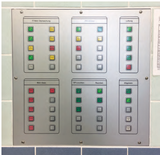
Stand 2001: Durch den Fliesenrahmen und die Einbauweise des Unterputzkastens war der Platz für den Einbau des neuen Melde- und Bedientableaus fest vorgegeben.
