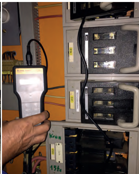
Fehlersuche mit dem portablen Isolationsfehlersuchgerät EDS195P
