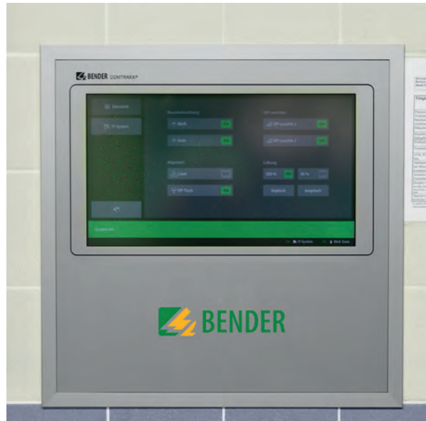
Stand 2018: CP915-F integriert in das vorhandene Fliesenschild
