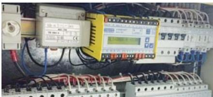
Aufgrund dieser erheblichen Vorteile – maximale Sicherheit bei minimalen Kosten – wurde die Installation des Sammlungsspeichers mit zwei ungeerdeten IT-Systemen ausgeführt. Sowohl das AV-Netz (Allgemeine Versorgung) als auch das SV-Netz (Sicherheitsversorgung), beide errichtet als dreiphasige AC-Netze, werden durch jeweils ein ISOMETER® der Serie IRDH260 überwacht. Im SV-Netz wird damit u. a. auch die Steuerung der Brandmelde- und CO<sub>2</sub>-Löschanlage ständig kontrolliert.
