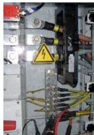
Zur Reduzierung der systembedingten Netzurückwirkungen und Erhöhung der Maschinenverfügbarkeit wird das Antriebssystem durch ein IT-System gespeist, welches durch einen Trans-
