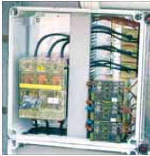
Weichenheizungssteuerung mit drei Relais und Wandlern
