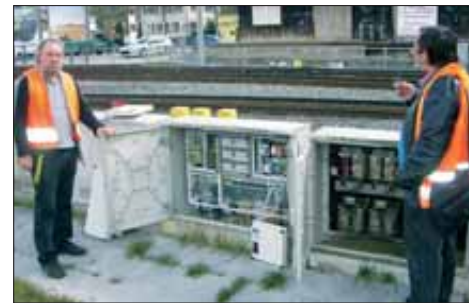
Komplette Steuerungseinheit mit Trenntrafos
