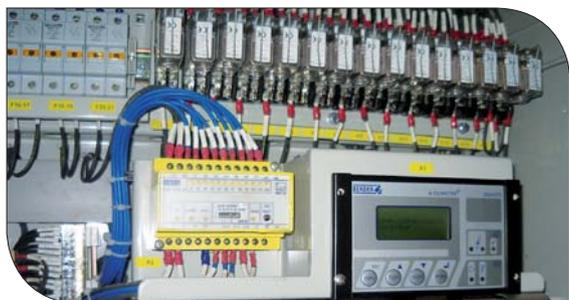
Informationen aus dem kommunikationsfähigen EDS auf das standardisierte und weit verbreitete Modbus-RTU Format umgesetzt. Somit wird den Ansprüchen an Kommunikationsfähigkeit, Datentransparenz und Flexibilität in einem hohen Maße Rechnung getragen.
