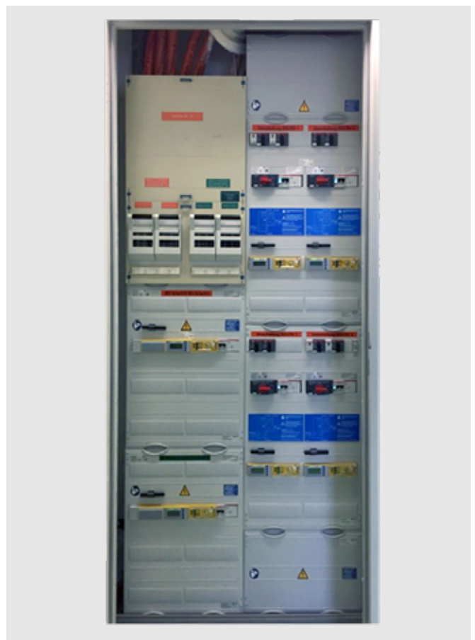
Détail d'une nouvelle installation
