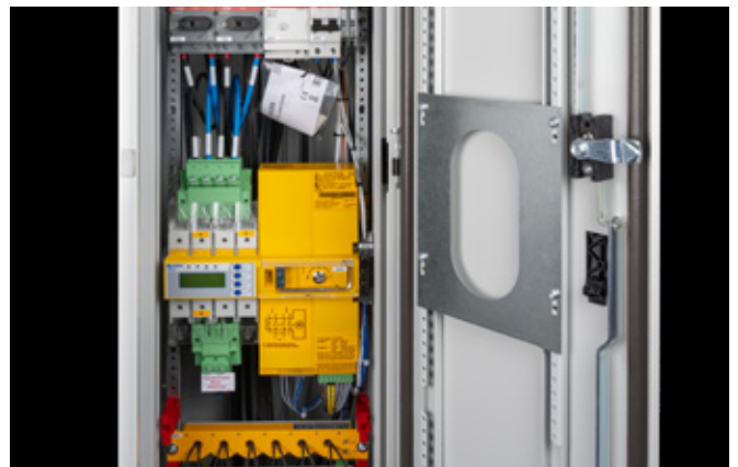
Détail d'une nouvelle installation
